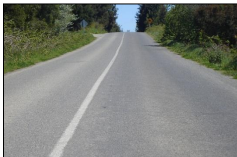
Camino con Capa Asfáltica
